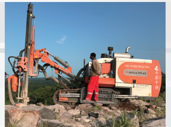
D545 埃塞俄比亚·公路建设 D545 Construcción de carreteras, Etiopía
