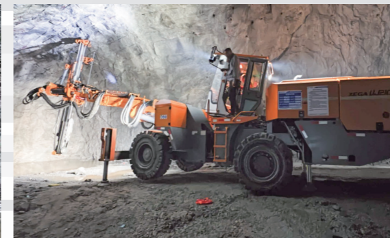
UJ21C 山东·核电站项目 UJ21C Shandong · Nuclear power station
