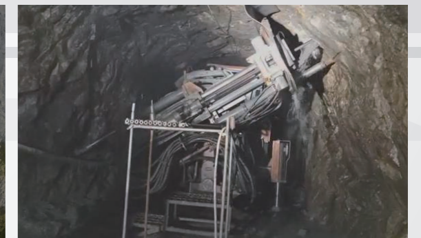
UP31A 江西·铜矿项目 UP31A Jiangxi · Copper mine
